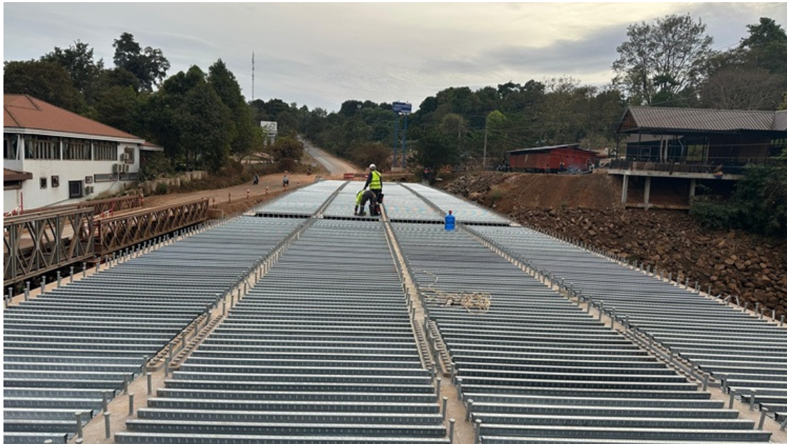
Brug in aanbouw met opbouw duidelijk te zien: langsliggers, zwaluwstaartprofielen en doken
