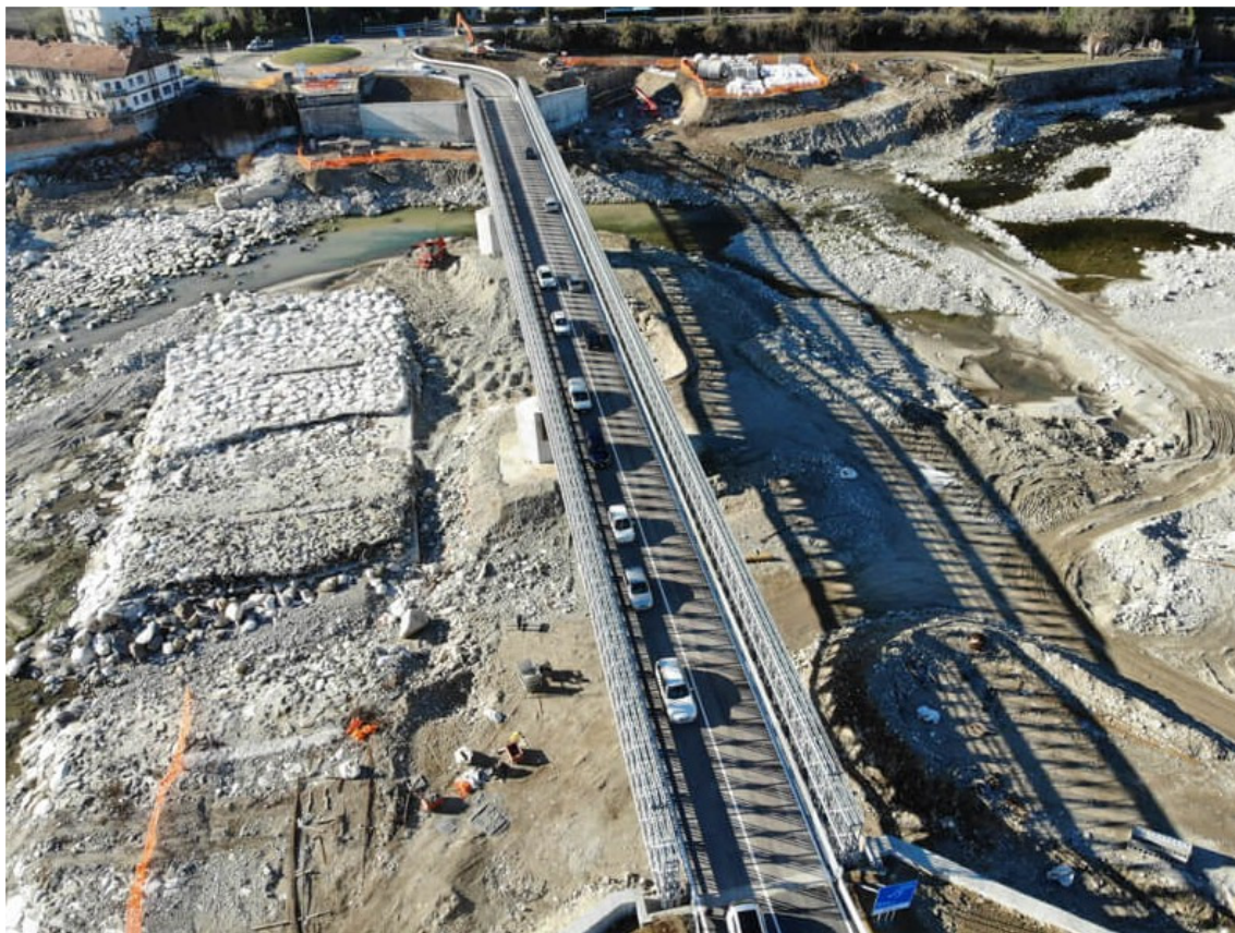
Tijdelijke brug bij Romagnano (Italië)
