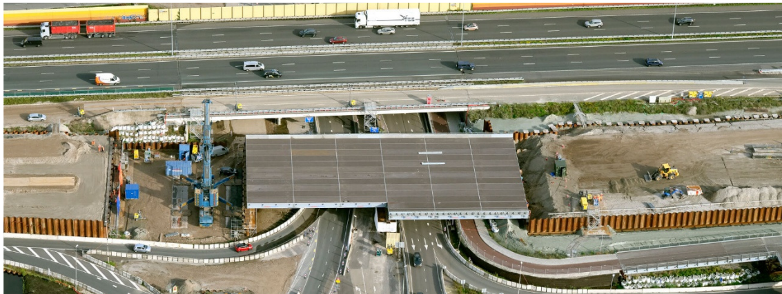
Realisatie tijdelijke brug in de A9
